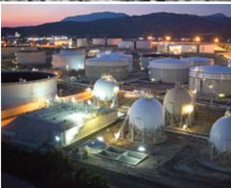
Άποψη του χώρου δεξαμενών υγραερίου (2009)
