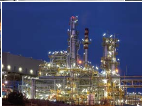
Άποψη της Μονάδας Ατμοσφαιρικής Απόσταξης (2010)
